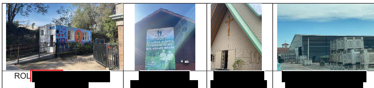
Imagen N° 9: Edificaciones sin recepción final.
