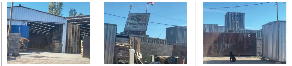
Imagen N° 6: Edificaciones de bodegas sin patente comercial.
