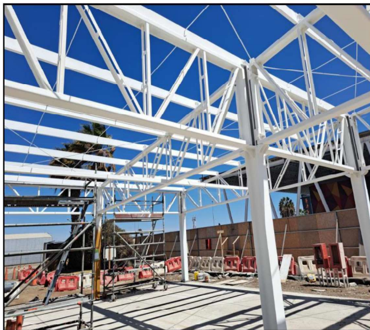
Foto-1: Vista general Edificio ARO – Control espesores (DFT) Intumescente
