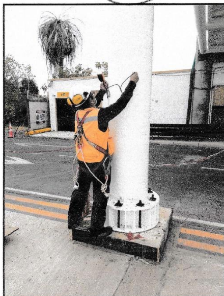
Foto-1: Control espesores DFT – Torre Iluminación N°8
