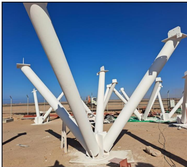
Foto-1: Vista General – Control Intumescente (DFT) Tretapodos
