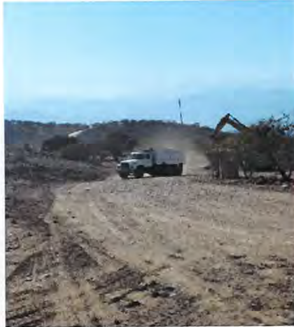
Imagen 5. Camiones al interior de las 563,6 ha. en faenas de construcción
